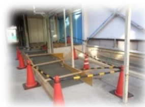
体育館スロープ工事
