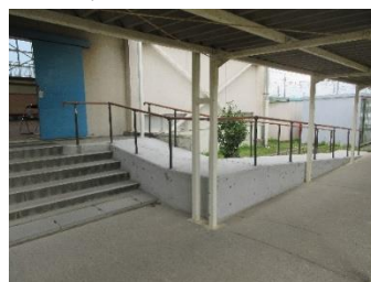
【4月中旬、体育館出入口にスロープが設置されました。】
